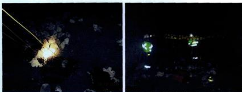
Imagen 12. Barreno cargado y retacado listo para realizar la voladura.
