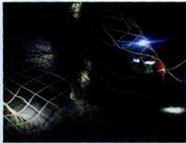
Imagen 01. Estado deficiente de la malla
