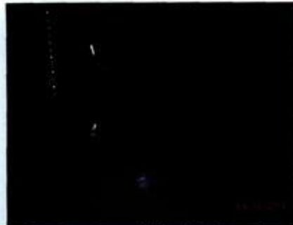
Imagen 14. Sector del túnel sin iluminación
