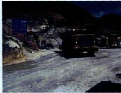
Imagen 19. Ingreso al túnel por el portal oeste.
