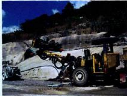
Imagen 22. Área de estacionamiento de maquinaria y lavadero de la misma.
