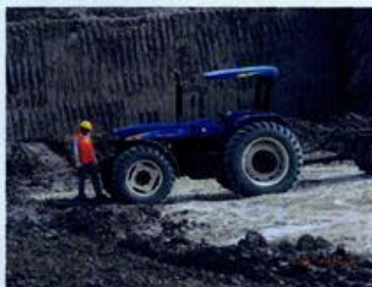
Imagen 31. Maquinaria dentro del patio de colas.
