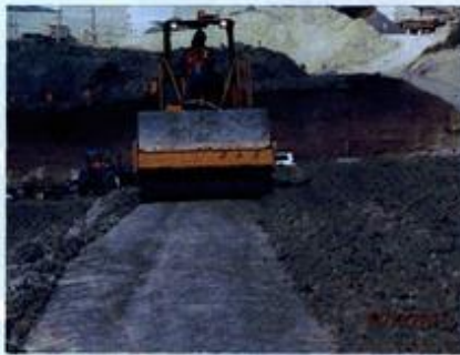
Imagen 27. Rodillo de compactación pasando sobre las colas.
