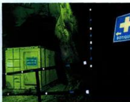
Imagen 16. Nicho o refugio de seguridad.
