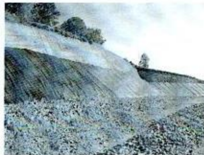
Imagen 16 y 17. Taludes con protección de geotextil cubierta por material estéril de la mina.
