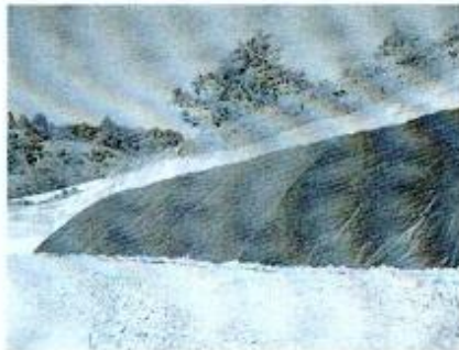
Imagen 16 y 17. Taludes con protección de geotextil cubierta por material estéril de la mina.
