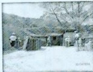
Aquí se observa el taller de soldadura al inicio de su implementación en este sector después de estar ubicada frente al túnel, rampa oeste.
