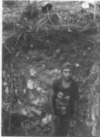
FOTOGRAFÍA 3. Preparación de terraplén para la ubicación de pozos de perforación. Coordenadas E806818.62, N1601384.69
