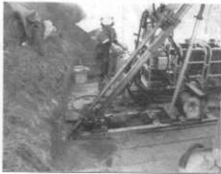
FOTOGRAFIA 2. Máquina de perforación.
