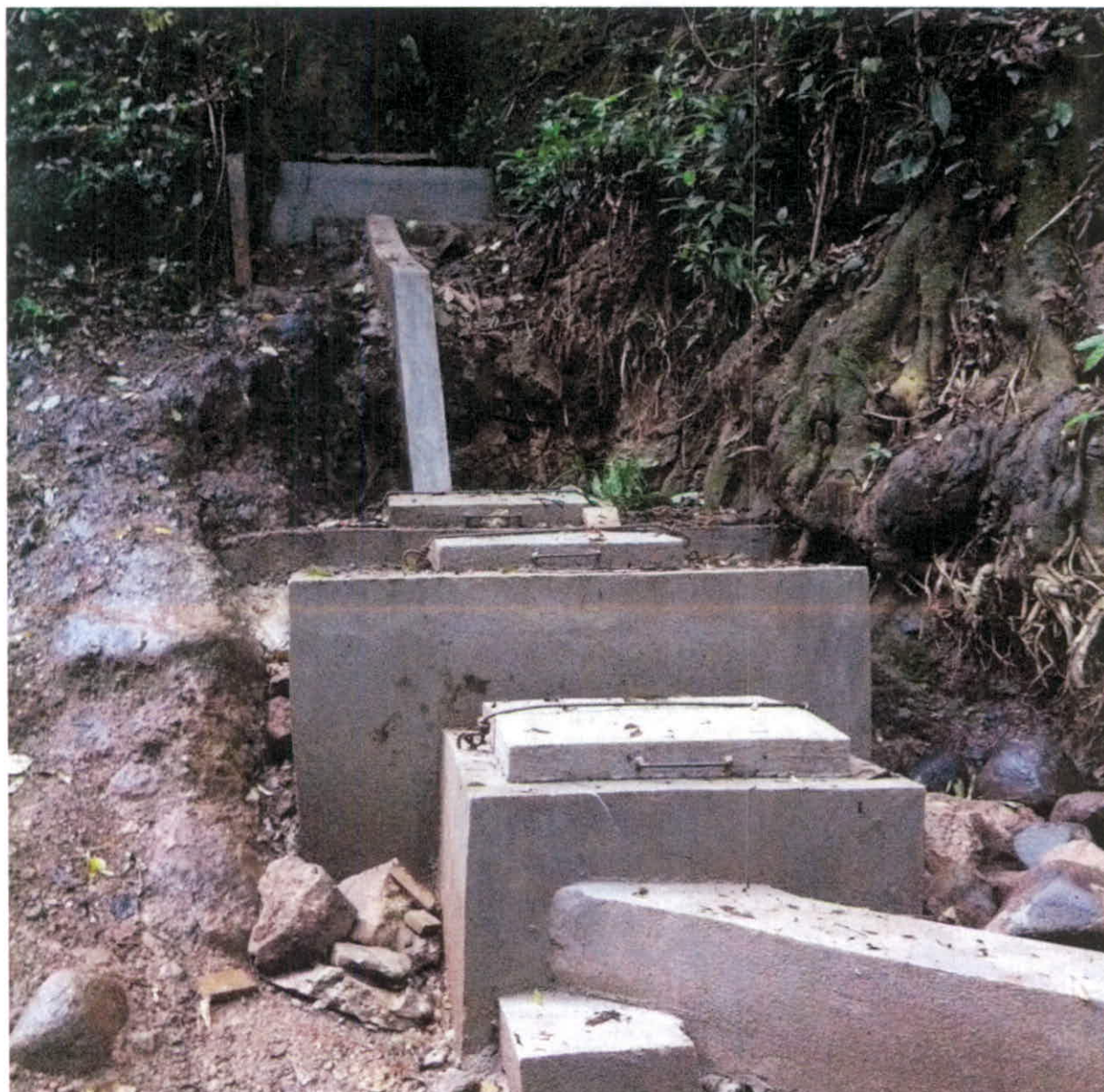
Rehabilitación de sistema de agua en aldea El Chan Grande
