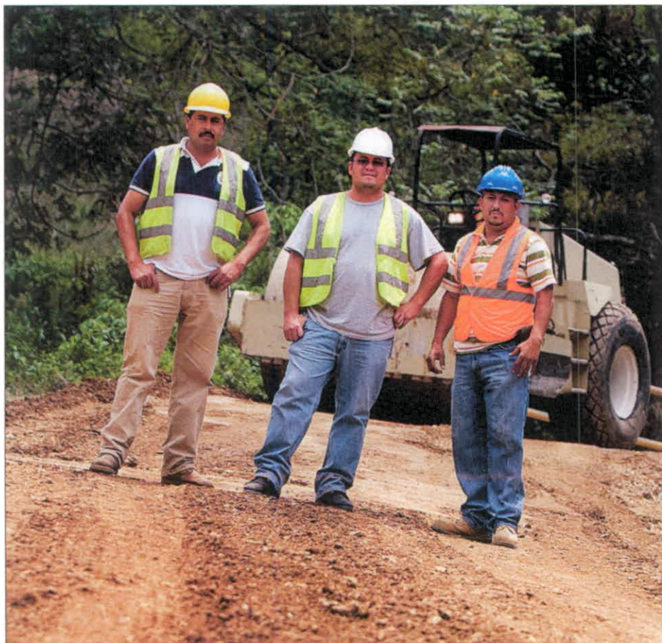
Contratistas locales rehabilitando el camino a El Fucío.
