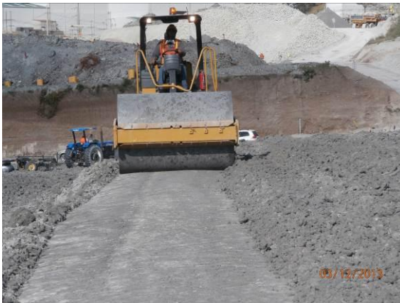
Imagen 27. Rodo de compactación pasando sobre las colas.
