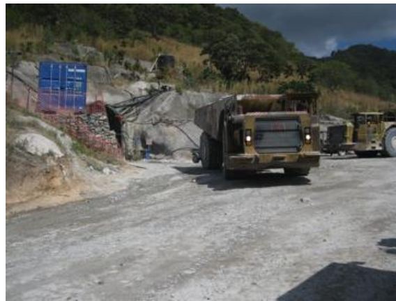
Imagen 19. Ingreso al túnel por el portal oeste.
