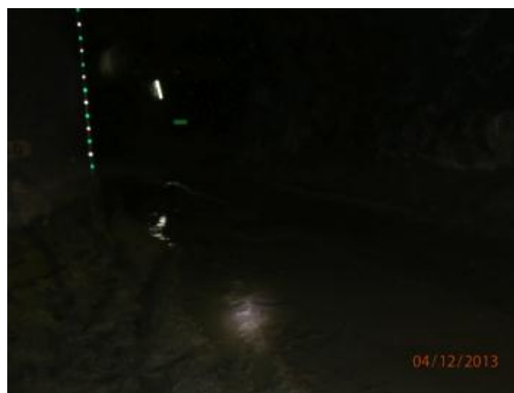
Imagen 14. Sector del túnel sin iluminación
