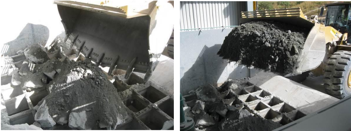
Imagen 34 y 35. Carga de material a trituradora primaria.
