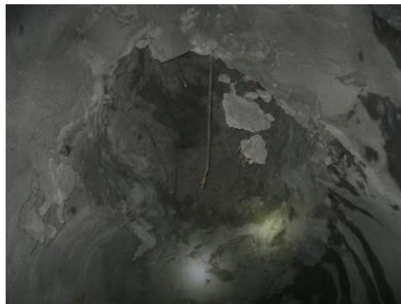
Imagen 03. Chimenea en el nivel 1365, la cual la están ensanchando y reforzando.
