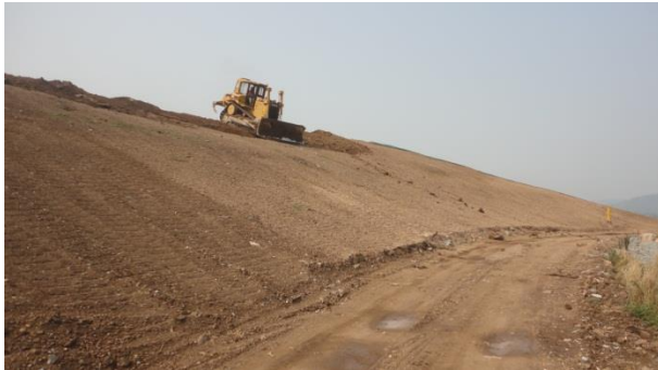
Fotografía 3-1. Movimiento de tierras realizadas en Top Soil. Mayo 2013
