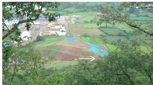
Fotografía 3-4. Depósitos de suelo sur. Junio 2013
