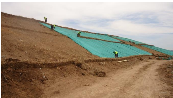
Fotografía 3-3. Trabajos finales de estabilización de talud en depósitos de suelo sur. Mayo 2013
