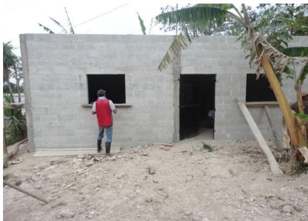
Fotografía 3-2. Construcción ubicada a aproximadamente 15 metros de estación EA-4A, marzo 2013
