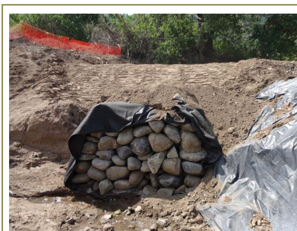
Fotografía 4-1. Canalización nacimiento GW-3 hacia la quebrada Escobal.
